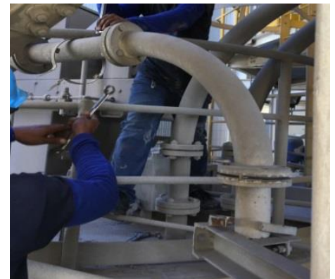
ท่อข้อต่อโค้งเซรามิกไลน์เนอร์ ที่ติดตั้งเสร็จ
