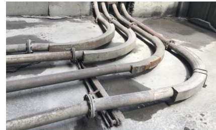
ท่อเสริมด้วยคอนกรีต
